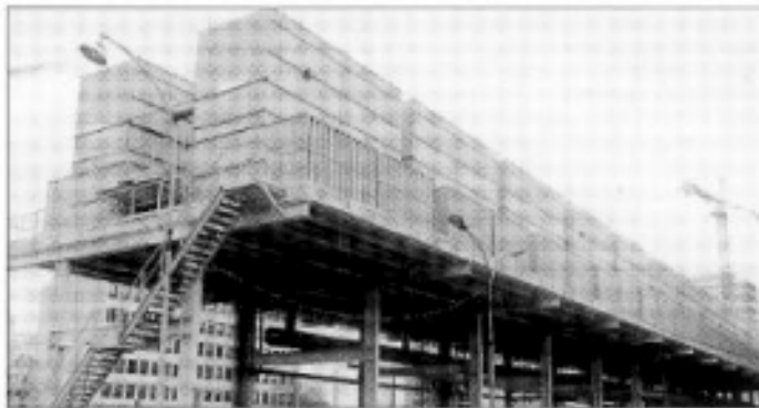
Конструкция с вентиляторами, расположенными с одной стороны
