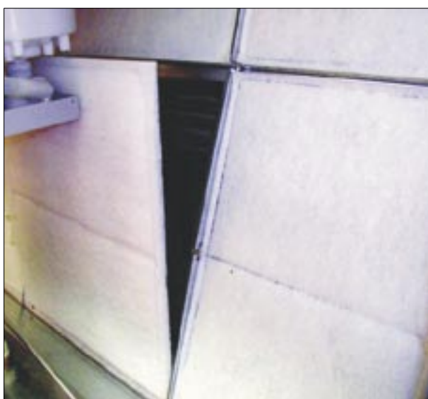
Рис. 10-3. Извлечение фильтрующего элемента из рамы
