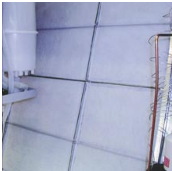
Рис. 10-1. Воздушный фильтр в сборе
